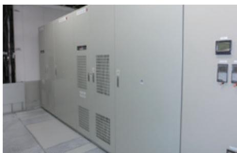
電気室内に蓄電システム2セットを列盤で設置
